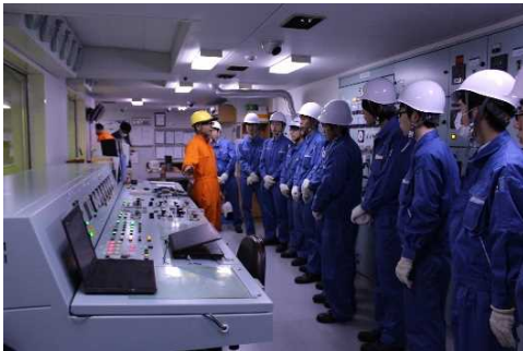
【ときわ丸機関制御室】
