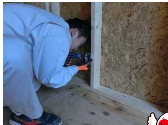
【照明用スイッチ・コンセント配線工事】
