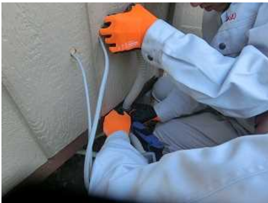
【電源100[V]・電源200[V]引込工事】
