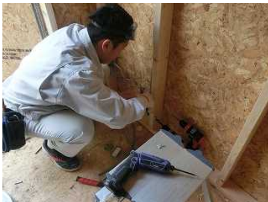
【照明用スイッチ・コンセント配線工事】
