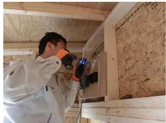
【分電盤の設置工事】
