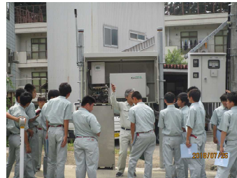
リニューアル井戸の現場
