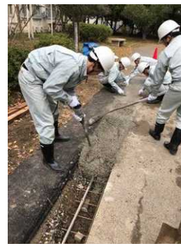
【井戸の掘削】 → 【ヒートパイプ立て込み】 → 【アスファルト舗装】 → 【コンクリート舗装】 → 【作業終了 養生中】
