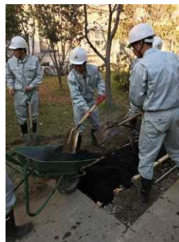
【井戸の掘削】 → 【ヒートパイプ立て込み】 → 【アスファルト舗装】 → 【コンクリート舗装】 → 【作業終了 養生中】
