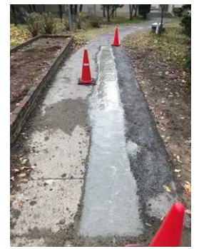
【井戸の掘削】 → 【ヒートパイプ立て込み】 → 【アスファルト舗装】 → 【コンクリート舗装】 → 【作業終了 養生中】
