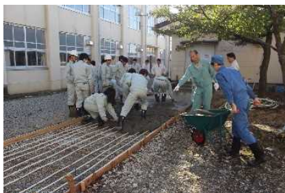
【コンクリート打設(土木・機械)】
