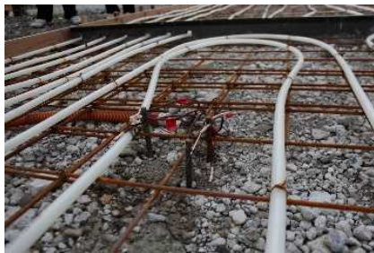
【熱電対設置(電気)】
