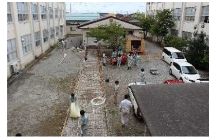
【配管施工(土木・機械)】
