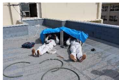
【太陽光パネル設置(電気)】
