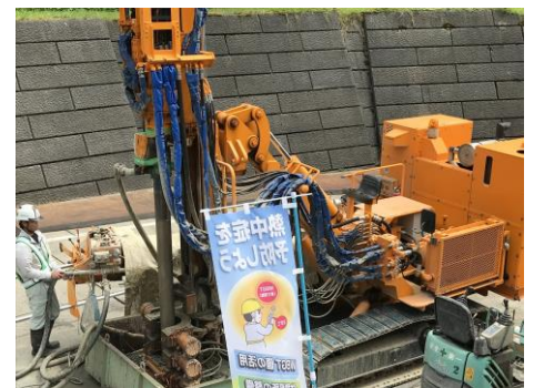
ロータリーパーカッションドリル 二重ケーシング・採熱孔崩壊を防ぐ
