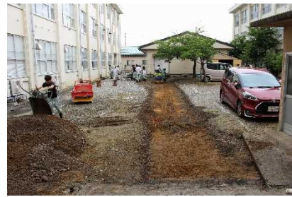
【猛暑の中の工事】
