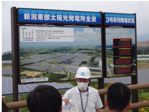
【発電設備の外観】
