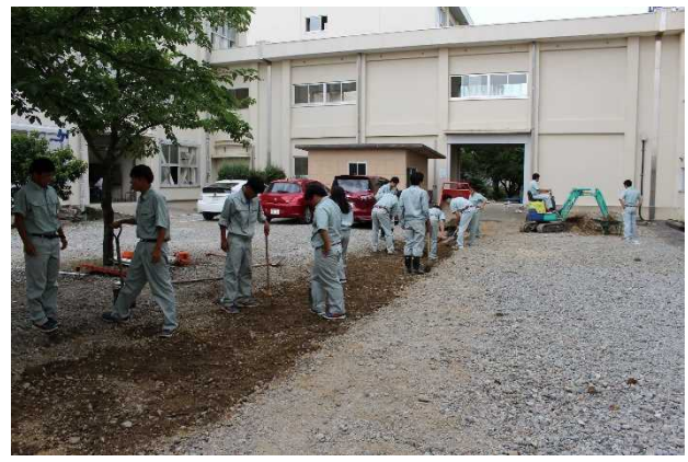
【同時進行の土木科ロードヒーティング施工風景】
