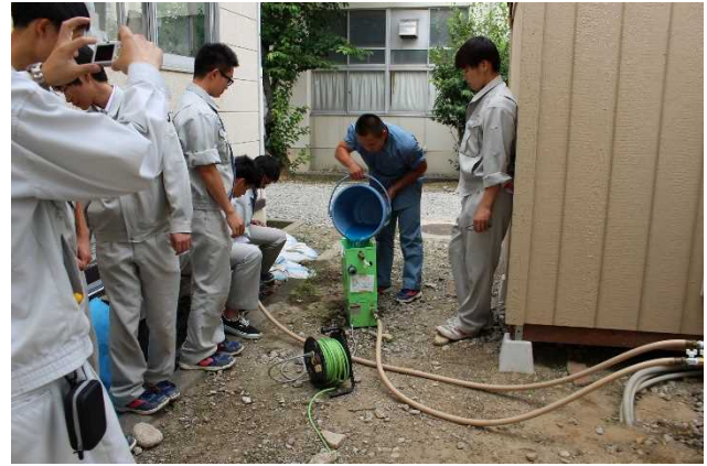
【配管への充填作業】
