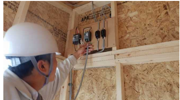
【電気科による電気工事風景①】
