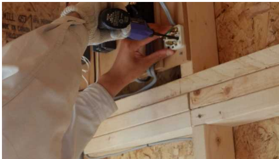
【電気科による電気工事風景②】
