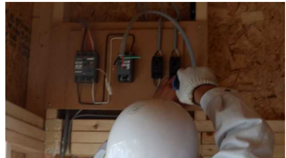
【電気科による電気工事風景③】
