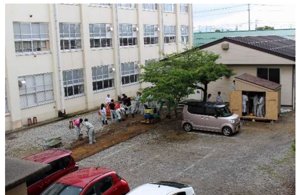
【同時刻に土木科がロードヒーティング工事】
