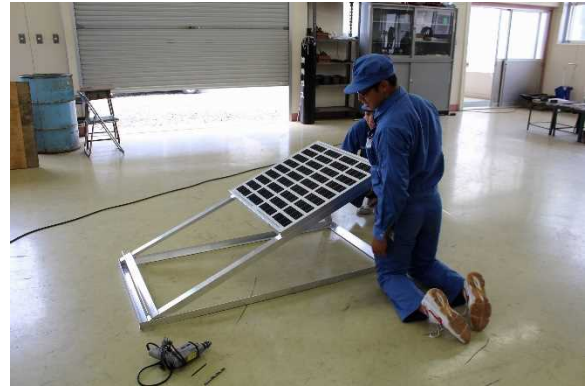
【パネル取付作業】
